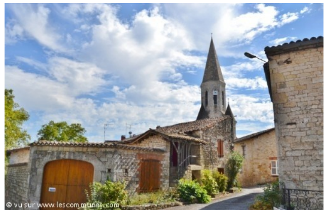
Ancien relais de poste
